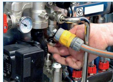
Nach Spülung aller Kreise, **zuerst die Füll- und Entleerhähne schließen** und danach die Wasserzufuhr beenden.
