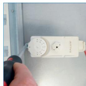
4. STB-Einstelleinheit an geeigneter Stelle im Verteilerschrank fest verschrauben.
