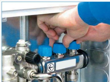
Nach Beendigung des Spülvorgangs, das Ventil schließen und gleichzeitig das Nächste öffnen.
