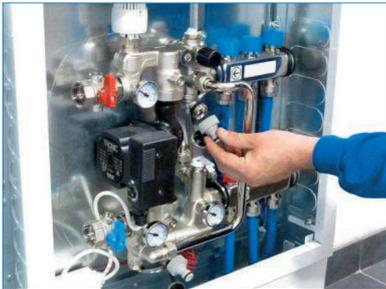
Schlauchadapter an beide Ventile montieren.
