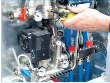
Oberen und unteren Pumpenkugelhahn schließen.
