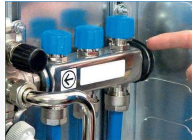
Den zu spülenden Kreis öffnen, alle anderen Rücklaufventile durch Drehen der Handverstellkappen schließen.
