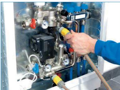
Den Füllschlauch am Rücklauf - oben -, den Entleerschlauch am Vorlauf - unten -, anschließen.
