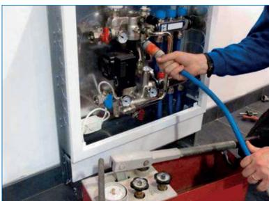
Alle Rücklaufventile für die Dichtigkeitsprüfung öffnen.
