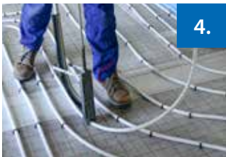
Abbildung 4: Fixierung des Systemrohrs
