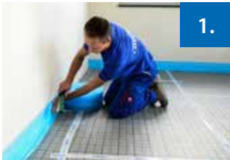
Abbildung 1: Randdämmstreifen
