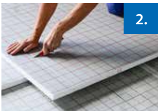
Abbildung 2: Verlegung Systemdämmung
