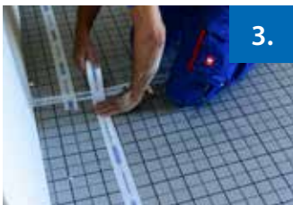
Abbildung 3: Verlegung Systemdämmung
