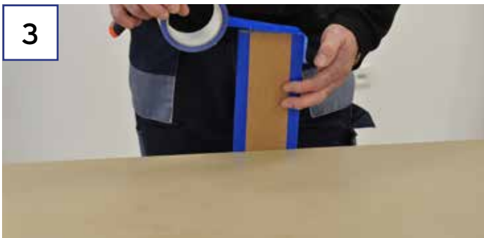
3 ENTKOPPLUNGSTREIFEN ABKLEBEN
