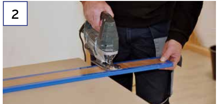
2 ENTKOPPLUNGSTREIFEN ZUSCHNEIDEN
