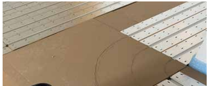
1. Rohrkanäle anzeichnen
